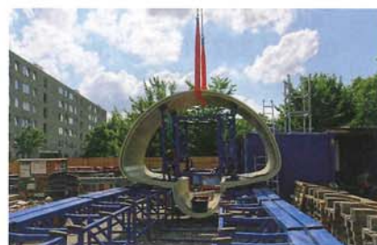
Aufnehmen eines Rohrstücks mit dem Lastkran
