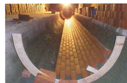
Auskleidung mittels Kanalklinker
