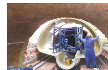
Einbringen eines Rohrstücks in den Kanal
