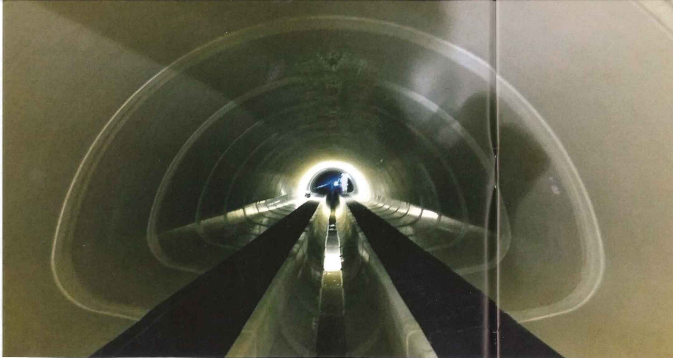
Auskleidung mittels Kanalklinker
